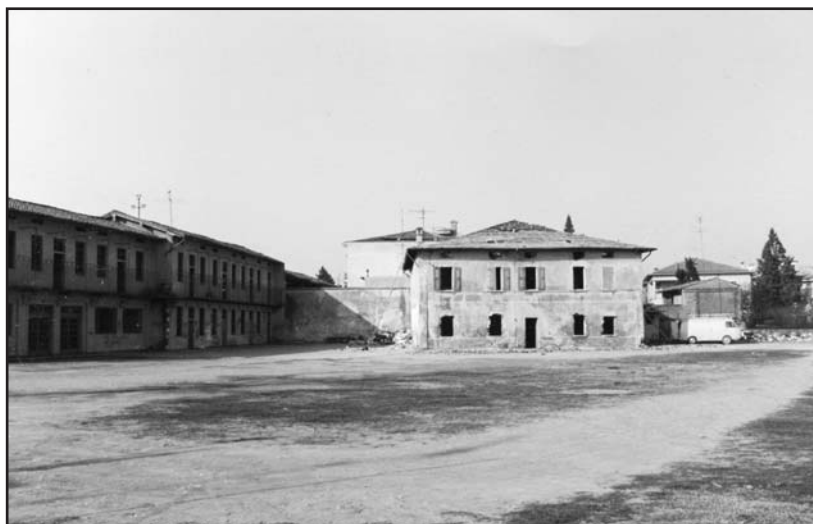
Il vecchio Oratorio maschile di via F. Cavallotti appena prima della demolizione per la costruzione dell'attuale complesso (Foto Gek dell'8-4-1980, g.c.). Ben riconoscibili gli edifici ricordati in questo articolo e il "glorioso" campo di calcio.
